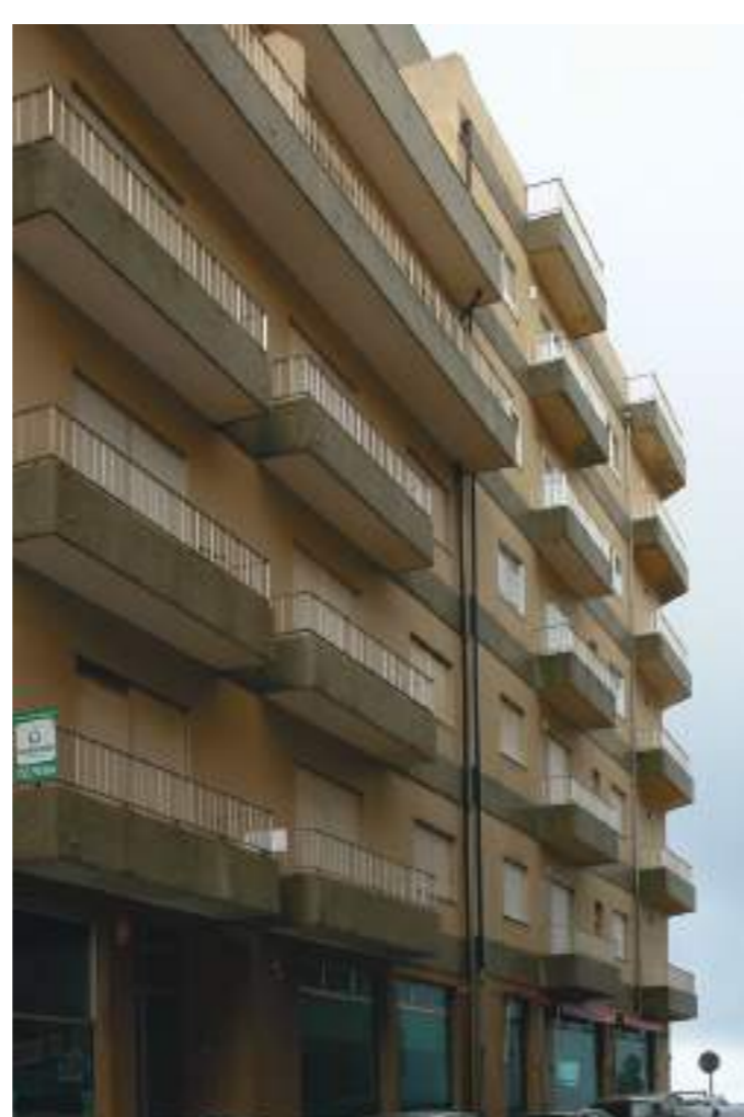
fachada norte (antes da intervenção)
