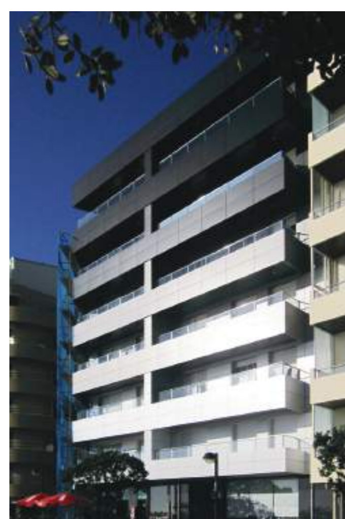
fachada poente (depois da intervenção)
