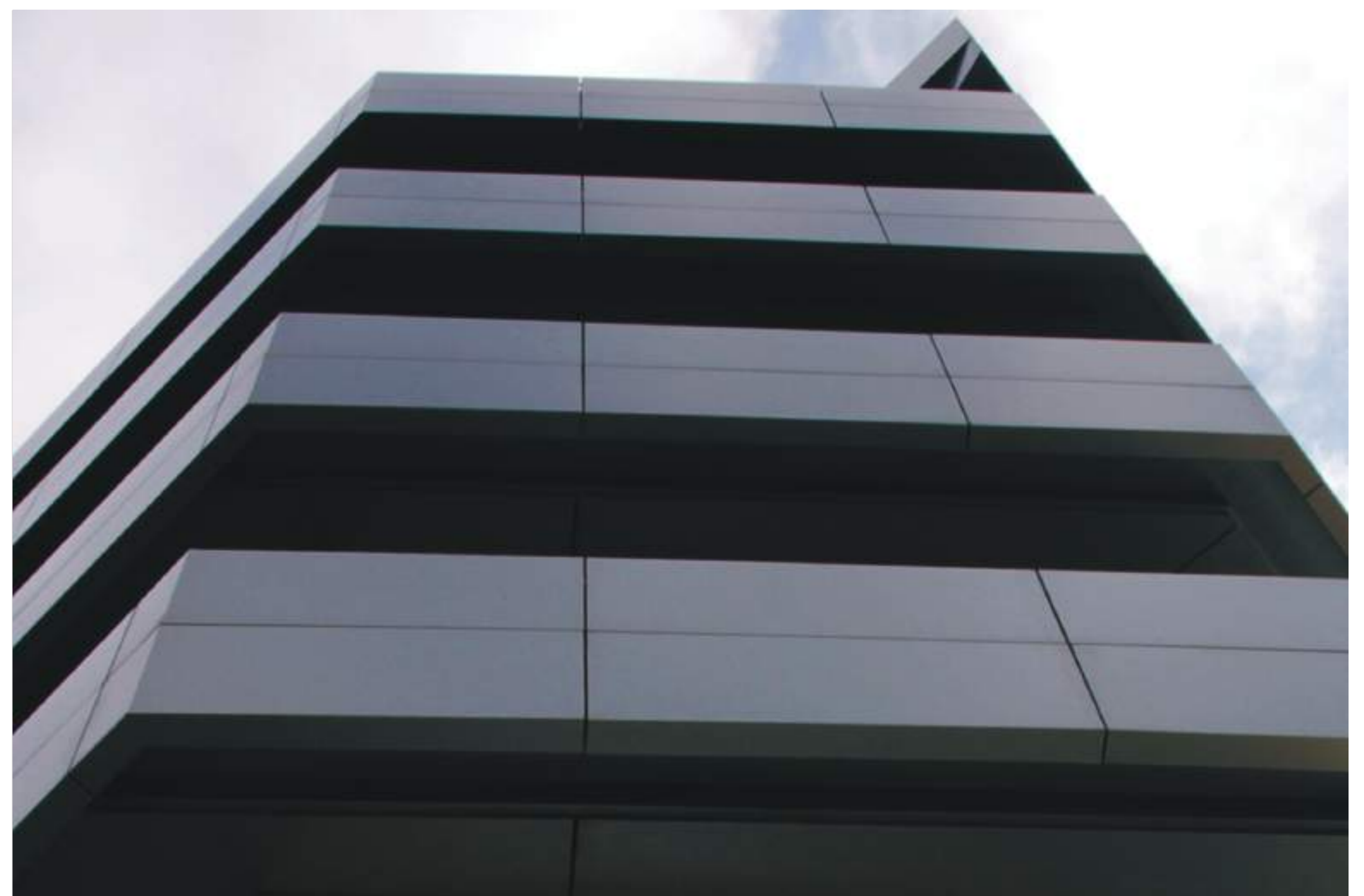
pormenor da fachada remodelada
