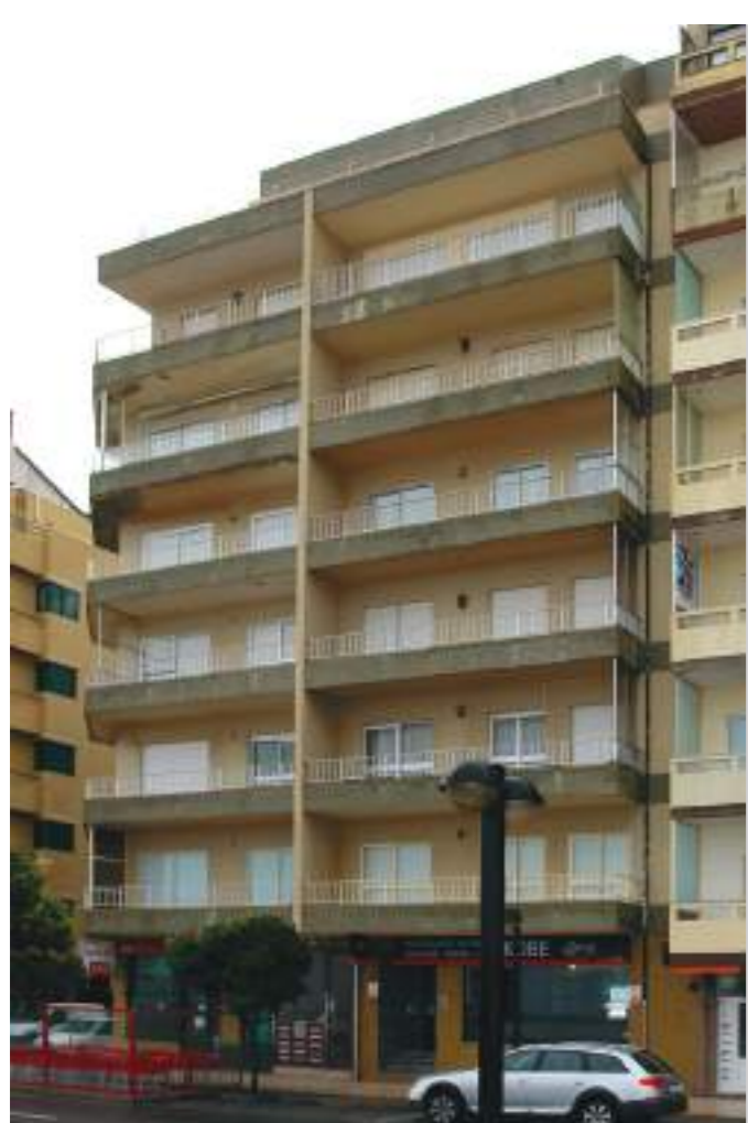
fachada poente (antes da intervenção)
