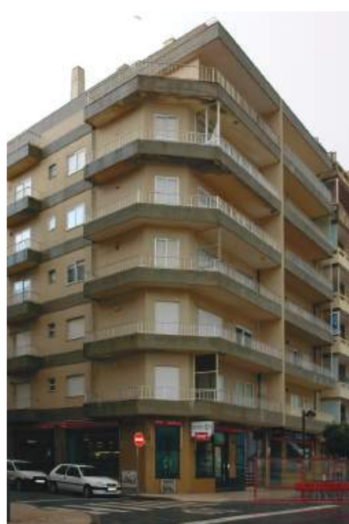
vista do gaveto (antes da intervenção)
