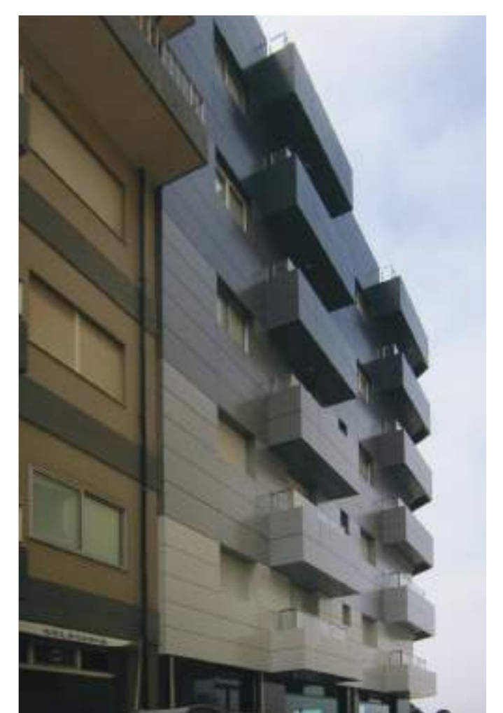
fachada norte (depois da intervenção)
