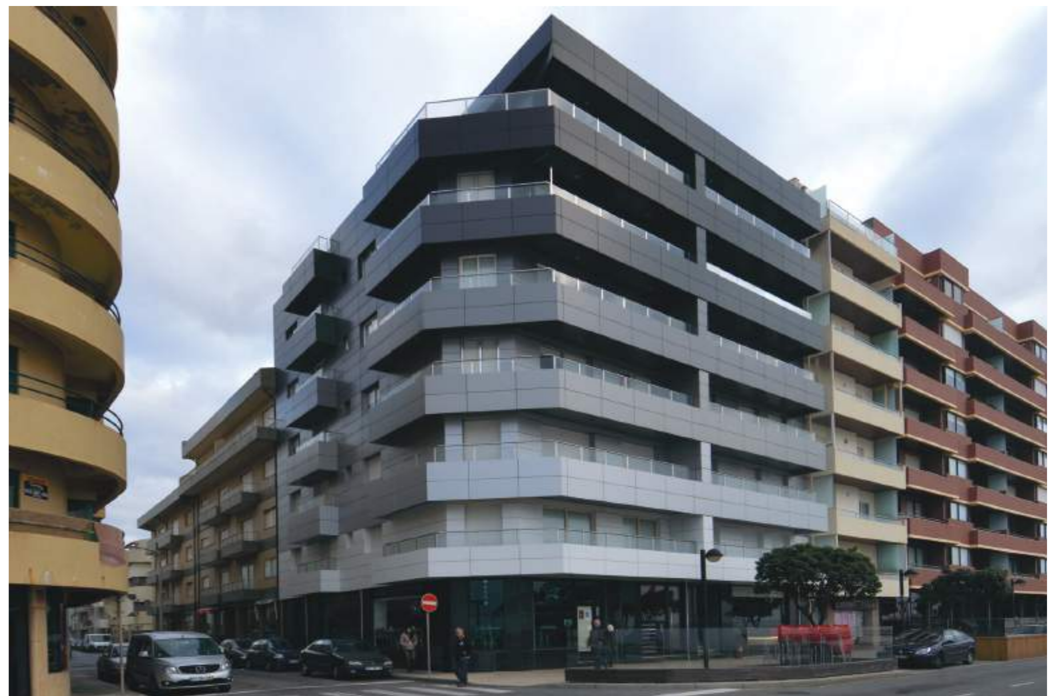
vista do edifício após a intervenção
